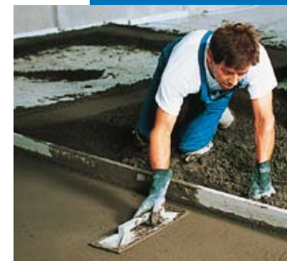
Finition par talochage du mélange Mapecem
