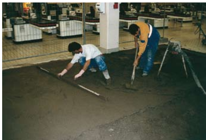
Réparation rapide d'une chape dans un supermarché
