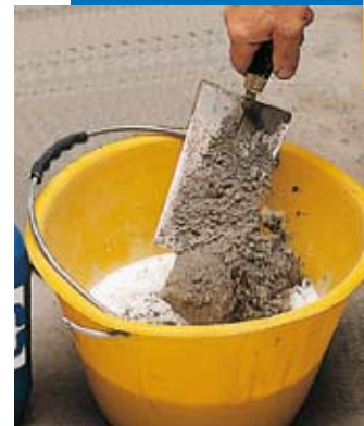
Préparation de la barbotine d'accrochage composée de Mapecem et Planicrete
