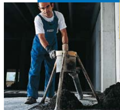
Alimentation du mélange Mapecem
