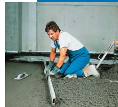
Étalage etamage du mélange Mapecem
